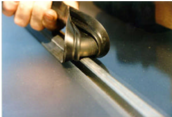
Figura 5.15: Applicazione della guarnizione di copertura.
