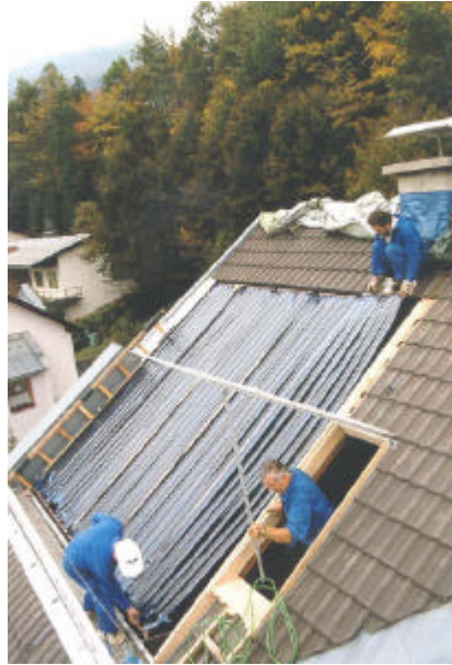
Figura 5.9: Collettore con strisce di assorbimento ad andamento verticale
