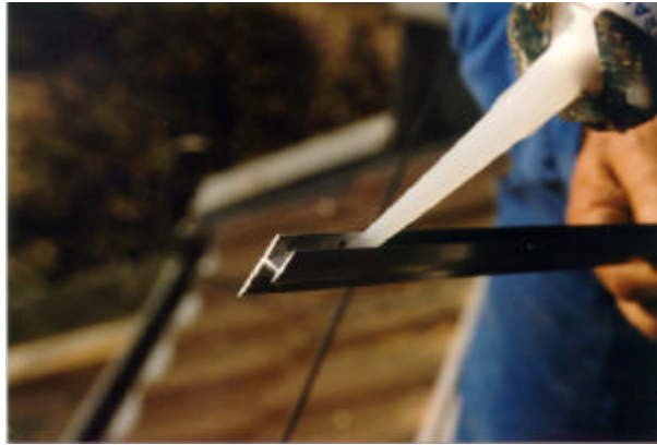
Figura 5.14: Inserimento del silicone nel profilo di alluminio ad H.
