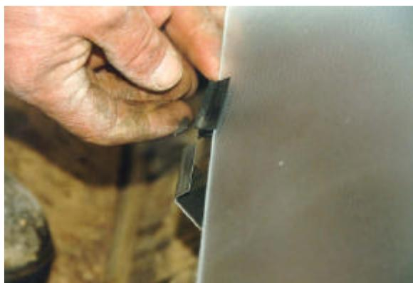
*Figura 5.12: Montaggio del gommino portavetro per la protezione dello spigolo della lastra.*
