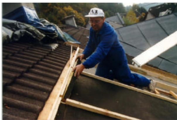
*Figura 5.7: Inserimento di un pannello di isolante.*
