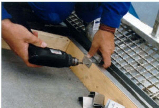
Figura 5.6: Montaggio dei supporti per il vetro.
