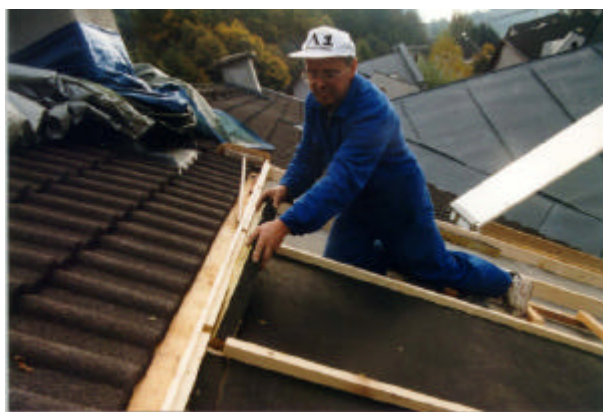
Figura 5.7: Inserimento di un pannello di isolante.
